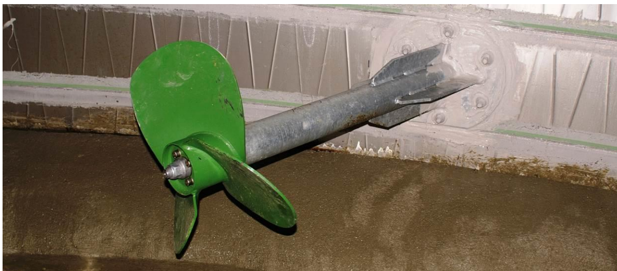
Abbildung 6: Sonderform eines Stabmixers mit kurzer Rührwelle, die knapp über dem Boden in den Behälter eingeführt ist
