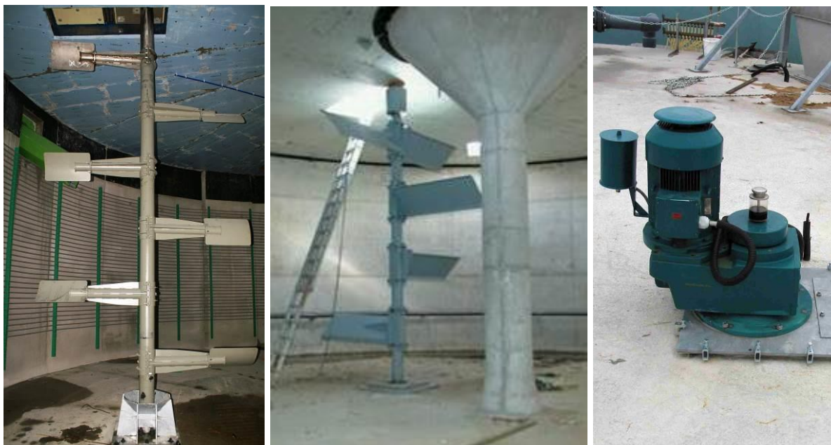
Abbildung 11: Vertikale Paddelrührwerke mit exzentrischer Anordnung und Antriebseinheit
