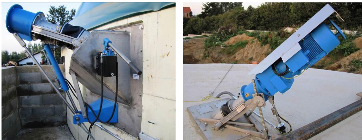
Abbildung 5: Wand- und Deckendurchgeführter Stabmixer mit hydraulischer (links) und mechanischer (rechts) Vorrichtung zur Verstellung der Wellenneigung
