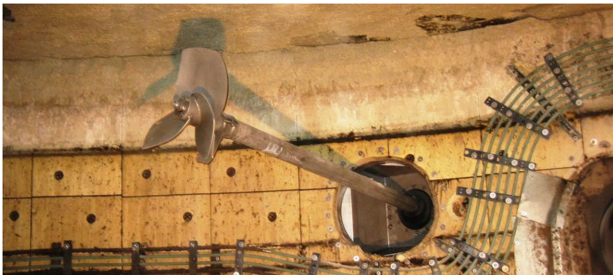
Abbildung 4: Schnelllaufender Stabmixer mit kleinerem Propeller, der im oberen Bereich durch die Gärbehälterwand geführt ist
