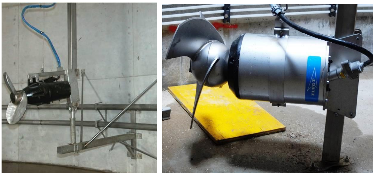
Abbildung 3: Schnelllaufendes Tauchmotor-Propellerrührwerk mit Kabelführung am Tragseil
