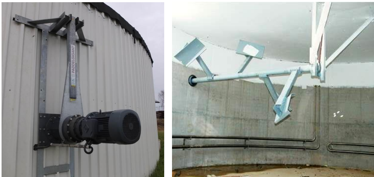
Abbildung 9: Hängendes Paddelrührwerk mit Antriebseinheit (Foto: LfL / agriKomp)
