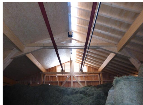
Kleine Heubelüftungshalle mit Boxen- und Rundballenbelüftung; Besonderheit: Firstentlüftung (Quelle: LfL, ILT 1b, S. Jakschitz-Wild, 2015)
