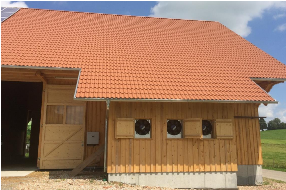
Abbildung 4: Beispielsbetrieb: Anbau mit Wärmerückgewinnungssystem, Axialventilatoren zur aktiven Absaugung der Abluft über dem Heustock durch den Wärmetauscher (Bildquelle: A. Schneider, Arwego)
