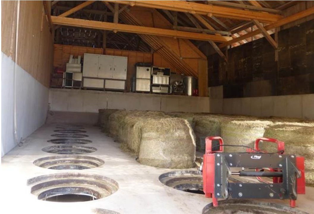
Abbildung 1: Selbstzentrierende Rundballenluftauslässe für variierende Ballengrößen einer hofeigenen Rundballenbelüftungsanlage (Bildquelle: S. Jakschitz-Wild, LfL)
