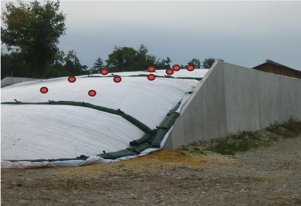
Abb. 4: Probenahme am Silo durch Einstiche von oben
