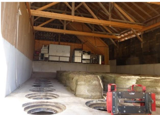
**Bild 9:** KWK-Nutzung Rundballenanlage auch für Lohn-trocknung (5 Reihen à 9 Auslässe) Besonderheit: selbst-zentrierende Auslässe für Ballendurchmesser 120 und 150 cm vorne rechts: Ballenzange (Quelle: S. Jakschitz-Wild, LfL)
