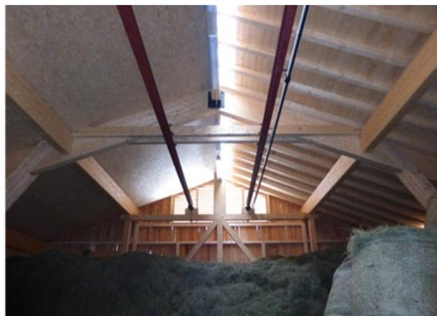
**Bild 10:** Kleine Heubelüftungshalle mit Boxen- und Rundballenbelüftung; Besonderheit: Firstentlüftung (Quelle: S. Jakschitz-Wild, LfL)
