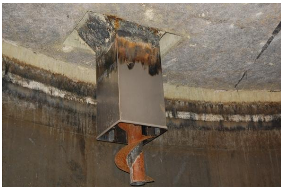
Abb. 3: Behälterdecke von unten
