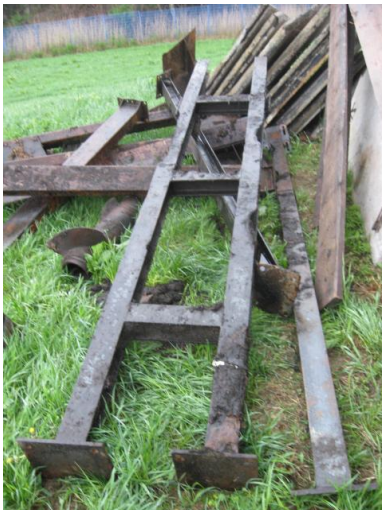
Abb. 1: Korrosion am Rührwerk
