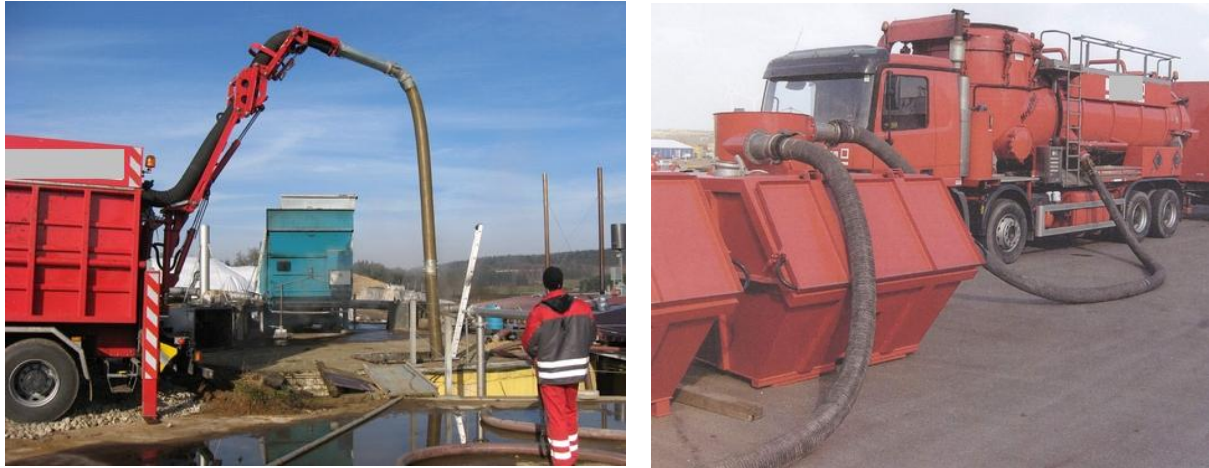
Abb. 7: Einsatz mobiler Hochleistungssaugergeräte zur Entfernung der Ablagerungen erleichtert die Arbeit und minimiert die Entstehung von gefährlichen Gasen
