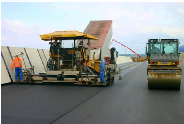
Abbildung 1: Einbau einer Trag- und Deckschicht aus Asphalt
