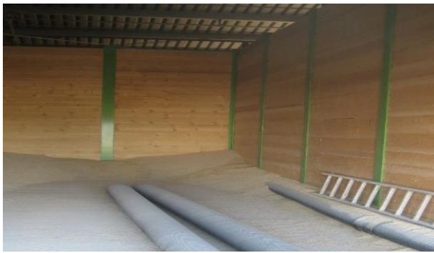
Warmbelüftungstrocknung im Flachlager
