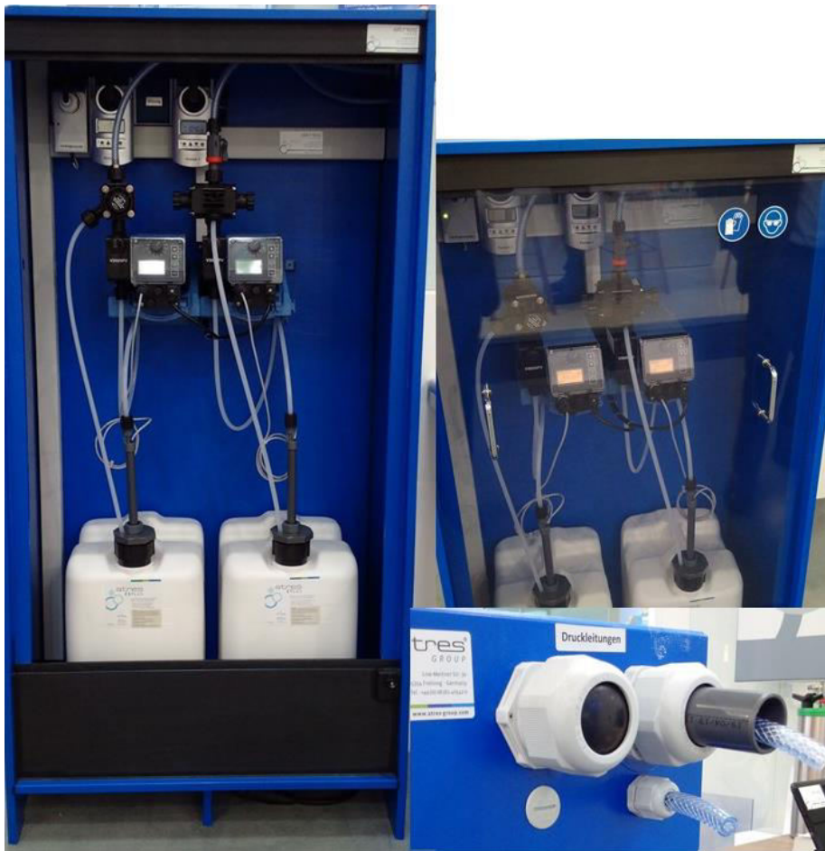
Abb. 8: Dosierstation für flüssige Prozesshilfsstoffe, rechts: mit abschließbarer Frontabdeckung aus PVC und Detailansicht der druckseitigen Produktleitungen (Schlauch-in-Rohr System); Anbieter: atres, Inh. Dipl.-Ing. Gunther Pesta; Bild: © atres
