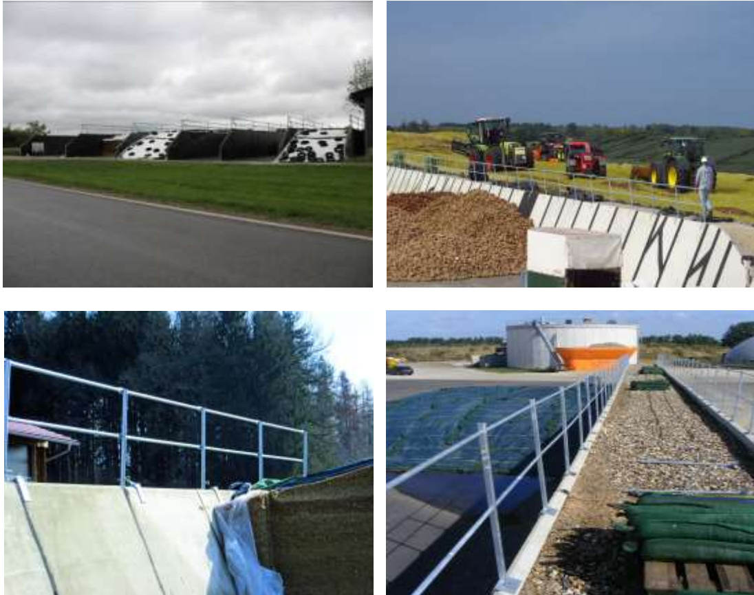
Abb. 10 – 13: Geländerbeispiele mit Knie- und Brustwehr
