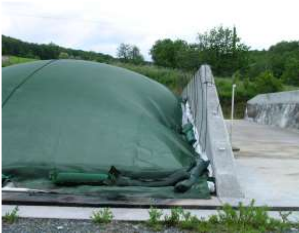
Abb. 31 + 32: Praxisbeispiele zu Beginn des Fermentierens mit „Gärgashaube“
