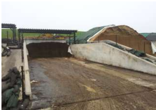
Abb. 40: Die Planenaufrolleinrichtung ist hier gleichzeitig die Absturzsicherung
