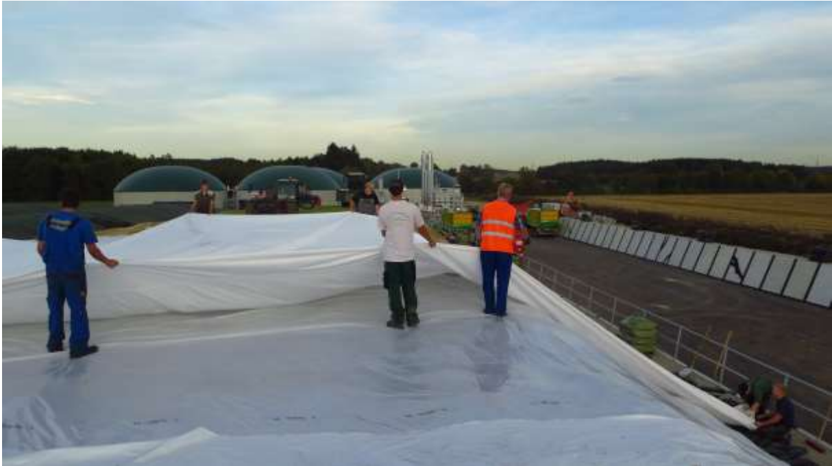
Abb. 35: Teamwork beim Abdecken mit Geländer gesichert (vorbildlich sind Helfer mit Warnweste)
