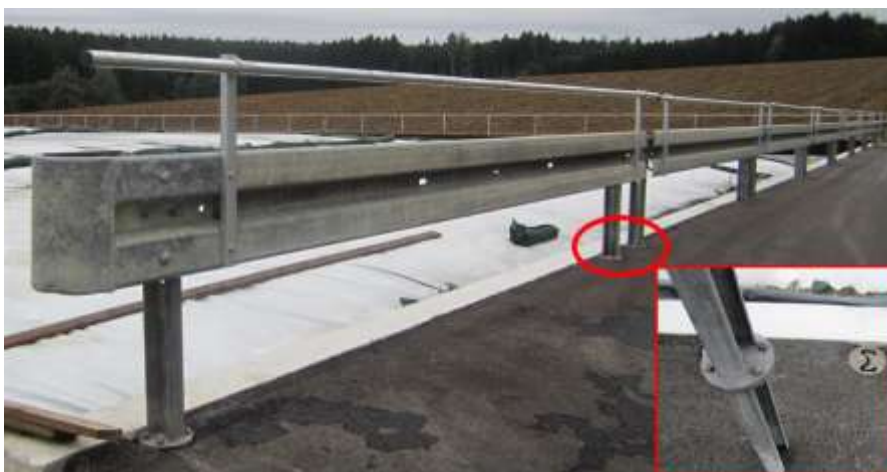
Abb. 9: Eingehaltener Anfahrsockel im Silo (30 cm)
