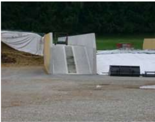
Abb. 23 – 26: Beispiele von Silokammerlaufstegen (die Anordnung bringt auch hohe Arbeitserleichterung beim Abdecken, ist aber unbedingt sauber zu halten)
