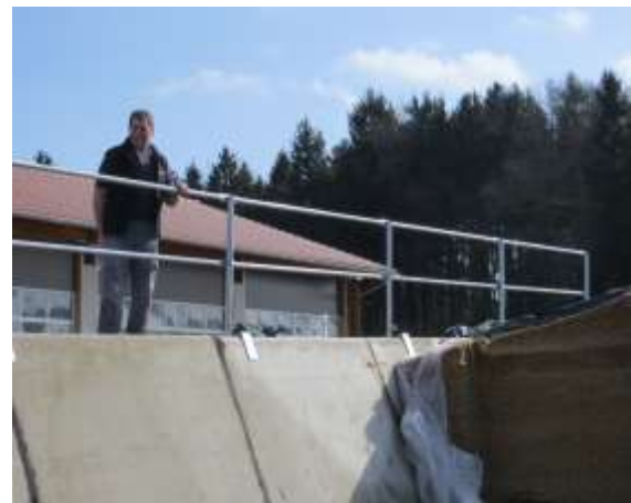
Abb. 41: Bei der Entnahme ist die Absturzsicherung stets mitzuführen
