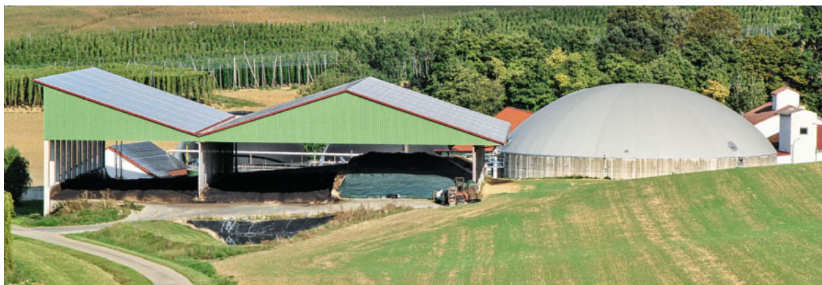
Die Biogasanlage von Martin Forstner in Eschenhart hat – zählt man alle BHKW zusammen – fast 1,6 Megawatt Maximalleistung, im Schnitt wird sie mit etwa 950 Kilowatt gefahren.
