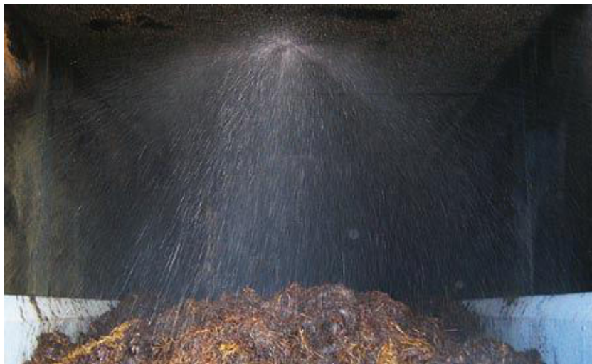
Abb. 22: Perkolatdusche im Trockenfermenter; Foto: C. Thoss
