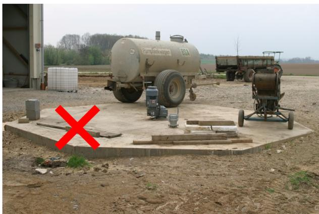
**Bild 1:** So nicht! Zur Atmosphäre hin offene Hydrolysegrube: das rote Kreuz kennzeichnet die mit Holzplanken abgedeckte Befüllöffnung (Foto: LfL)
