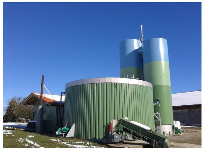
**Bild 2:** Im Vordergrund: Gasdichte wärmegegedämmte BIOVoltaik® - Hydrolysestufe mit Bodenrührwerk (links unten am Behälter), Oberrührwerk mit Frequenzumformer (rechts oben am Behälter) und Beschickungseinrichtung (Bildmitte am Behälter); rechts hinter der Hydrolysestufe: BIOVoltaik® - „Turbo-Höchstlastfermenter“ (Foto: BIOVoltaik® GmbH)
