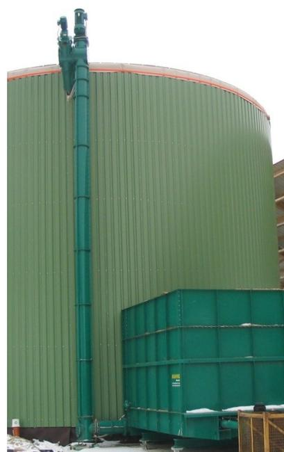
**Abb. 14 und 15:** Feststoff-Trocken-Eintragungssysteme mit Trog-, Steig- und Stopfschnecke (Fotos: LfL)
