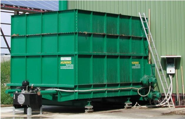
**Abb. 6:** Stahlcontainer mit Schubbodensystem;
