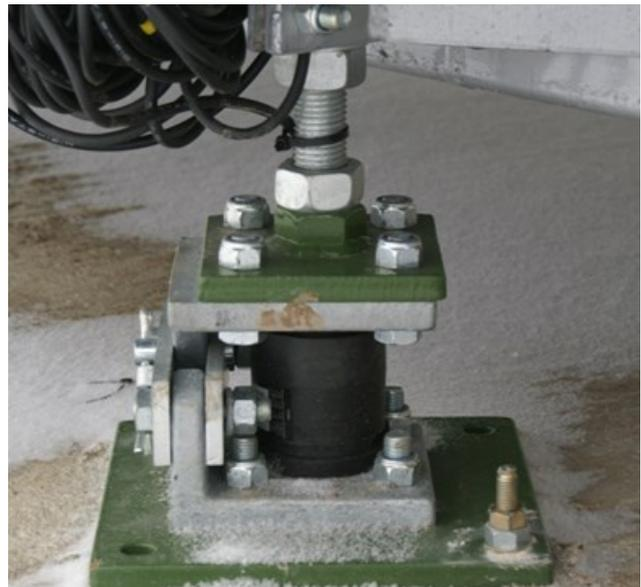
**Abb. 2:** Stützfuß eines Feststoffvorlagebehälters auf einer Wiegezelle (Foto: LfL).
