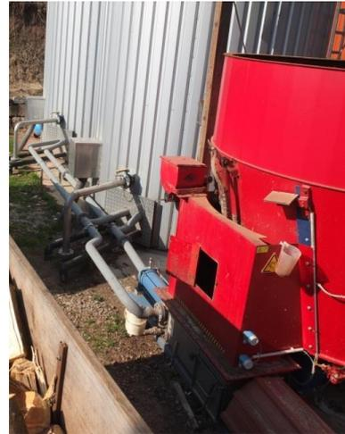
**Abb. 17 und 18:** Feststoff-Flüssig-Eintragssystem mit Exzentrerschneckenpumpe;
