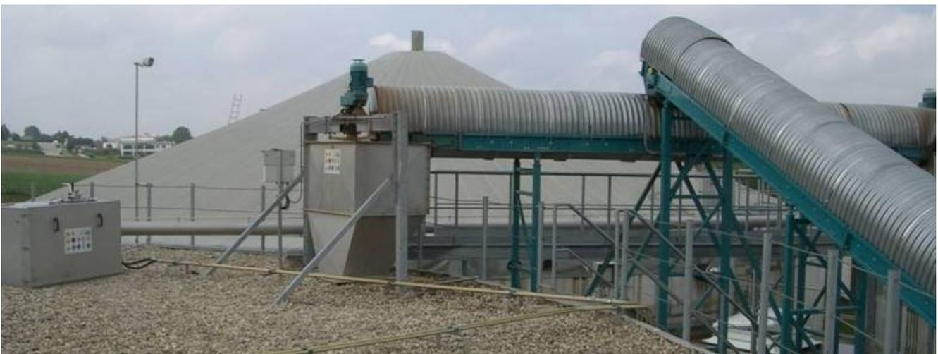
**Abb. 16:** Feststoff-Trocken-Eintragssystem mit Steigförderband, Querförderband und Stopfschnecke (Foto: Gutachtergemeinschaft Biogas GmbH)
