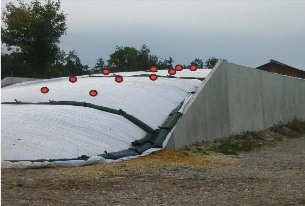
Abb. 4: Probenahme am Silo durch Einstiche von oben
