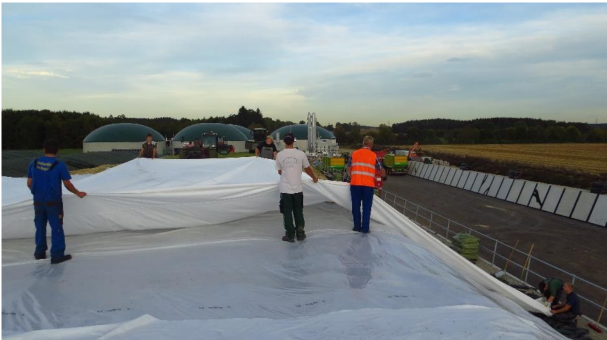
Abb. 37: Teamwork beim Abdecken mit Geländer gesichert (vorbildlich sind Helfer mit Warnweste)
