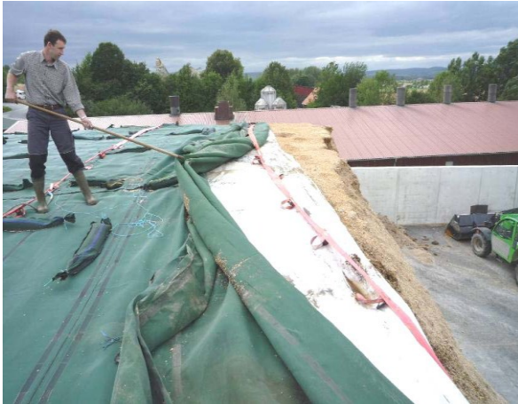
Abb. 38 + 39: mind. 2 m Sicherheitsabstand einhalten, Folien und Netze können mit Hilfsmitteln zurückgezogen werden
