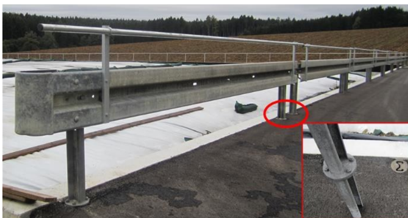
Abb. 9: Eingehaltener Anfahrsockel im Silo (30 cm)
