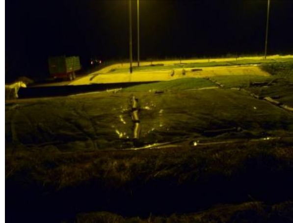
Abb. 36: Siloanlagen mit Beleuchtung bei Ernte und zur Entnahme sollten Standard sein
