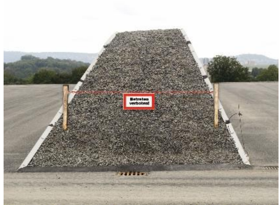
Abb. 27 + 28: Lösung gegen unbefugtes Betreten der Mittelwandkrone bei leeren Silokammern
