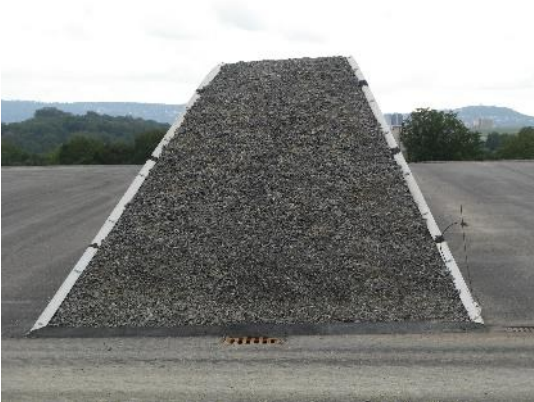
Abb. 27 + 28: Lösung gegen unbefugtes Betreten der Mittelwandkrone bei leeren Silokammern
