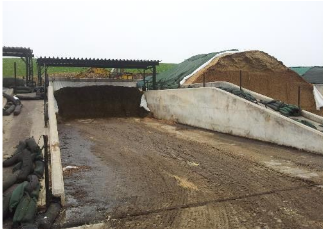
Abb. 42: Die Planenaufrolleinrichtung ist hier gleichzeitig die Absturzsicherung
