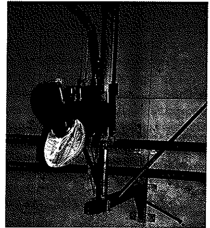
Tauchmotor-Propellerrührwerk: Installation im Behälter. Foto: LfL
