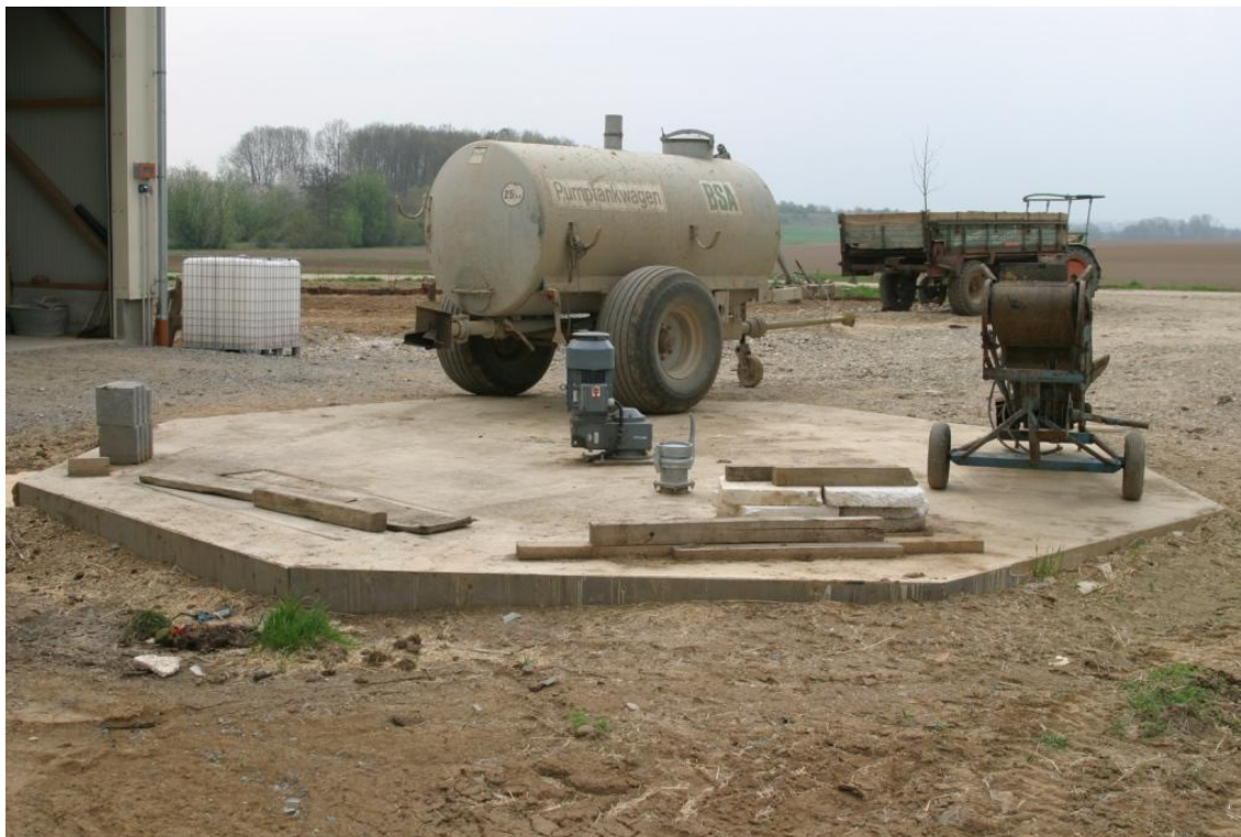
Abb. 2: So nicht! Zur Atmosphäre hin offene Hydrolysegrube (Foto: LfL)
